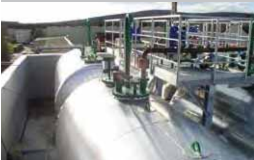
Dachtanklager, liegend in Feuerschutzwanne horizontal roof-top tank system in fire screen vat
