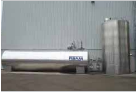
Tanklager für Harz und Härter storage tank for resin and hardener
